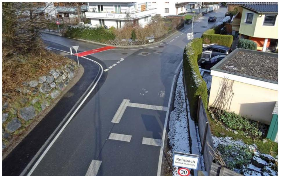
Die auffällige Markierung und der breite Mittelstreifen sind nur zwei der Verbesserungen in diesem Bereich.
