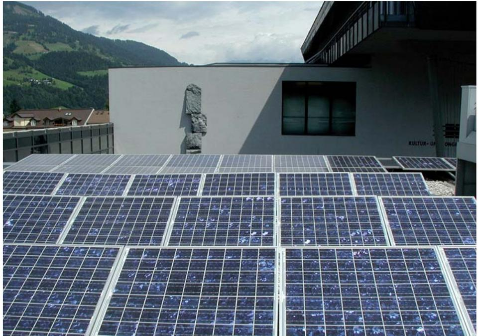
*Klimaschonende Energiegewinnung: Seit 2003 werden mit der Fotovoltaikanlage auf dem Dach des Kultur- und Kongresshauses jährlich ca. 11.000 kWh erzeugt.*
